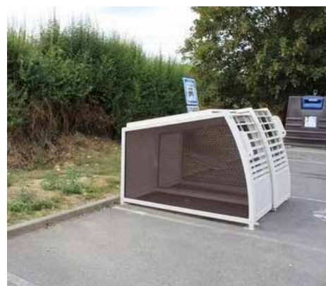
Local vélo sécurisé sur aire de covoiturage, Lésigny (77)
